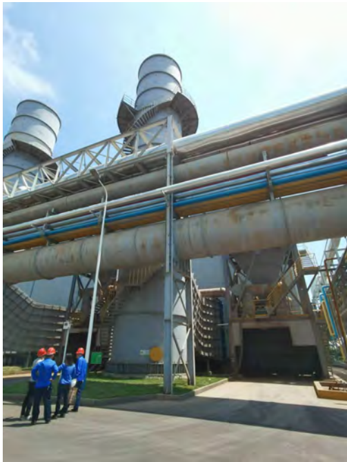
1#电炉废气排气筒
